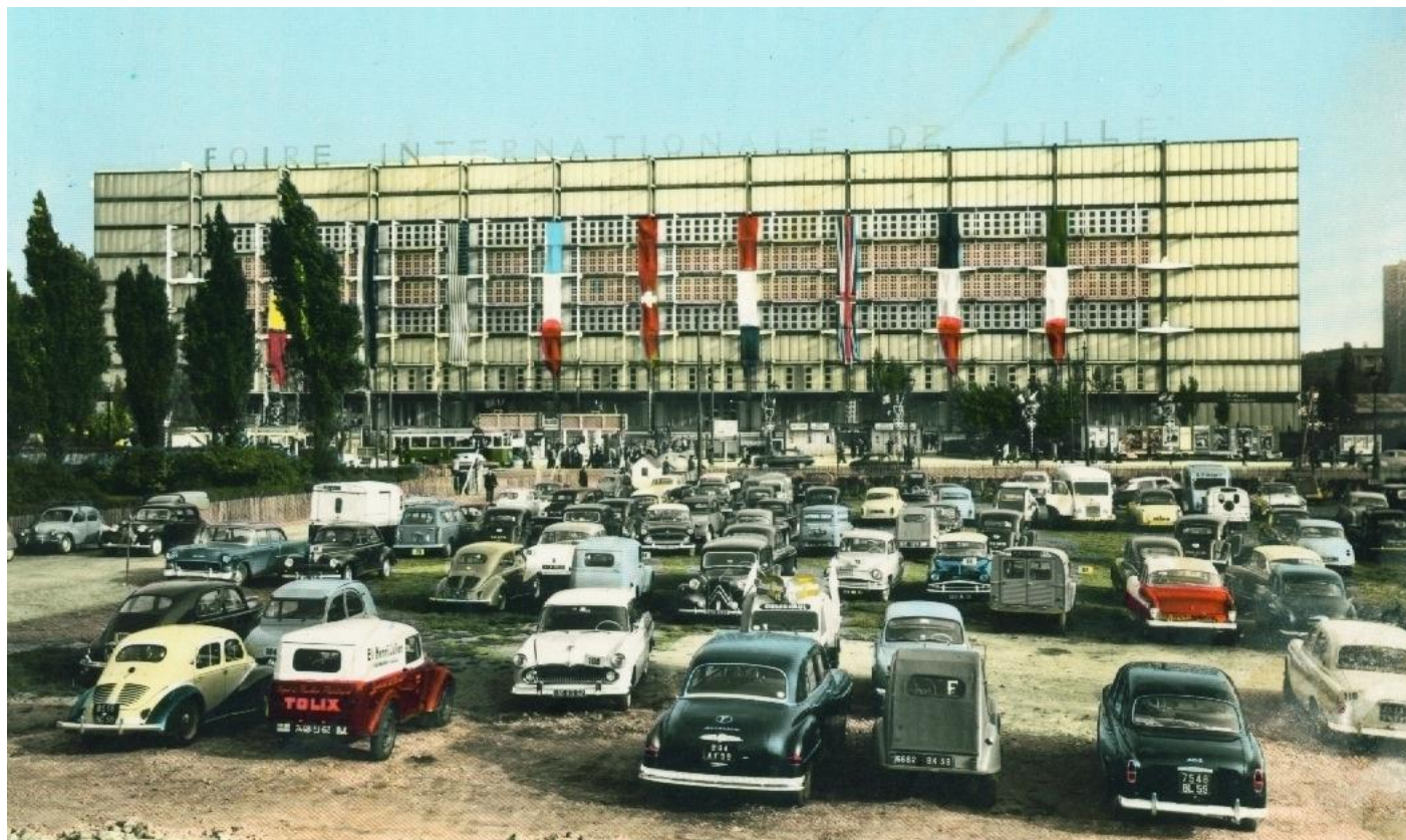
Le hall de la Foire à Lille où sera installée la piste démontable pour les Six Jours
